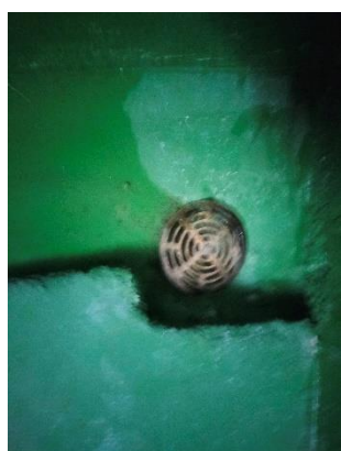
รูปที่ 2-17 ท่อรวมน้ำทิ้งในห้องพักมูลฝอยแต่ละประเภท
